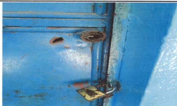
Foto 2: Sustitución de chapas.
