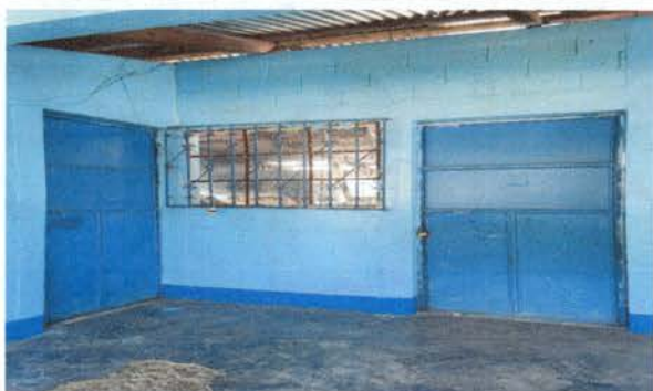
Foto 5: Sustitución de balcones de metal.
