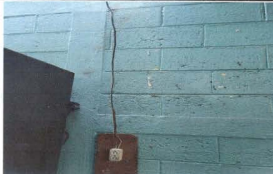
Foto 6: Sustitución de ducto electrico + accesorios.
