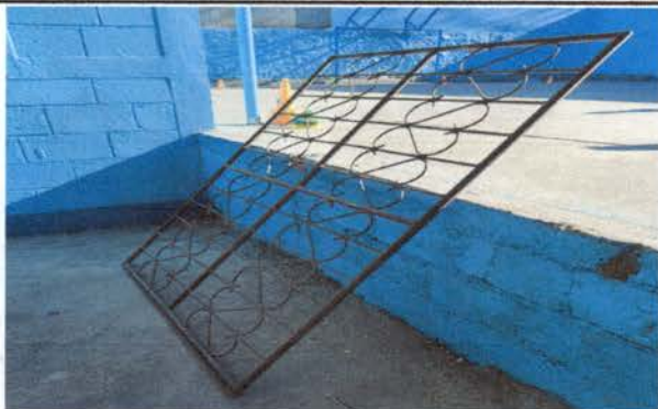
Foto 1: Mantenimiento a barandas de metal.
