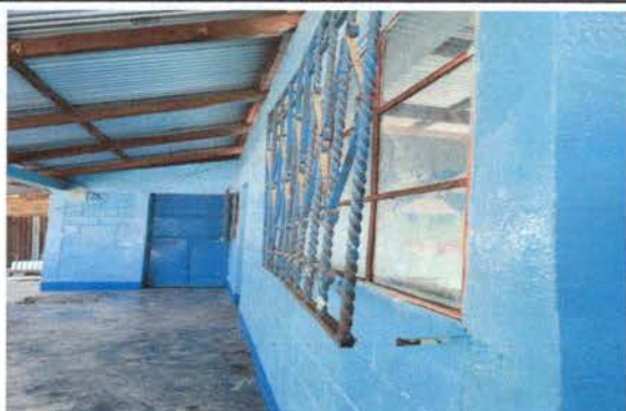
Foto 3: Mantenimiento de balcones de metal.
