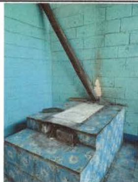
Foto 4: Sustitución de chimenea de concreto.
